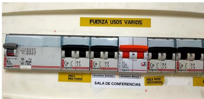
En la Sala se instaló un nuevo cuadro general de protección, con control de potencia por cada mesa y por el propio RAC de comunicaciones, así como una protección contra **SOBRETENSIONES** para la protección de los equipos informáticos.
