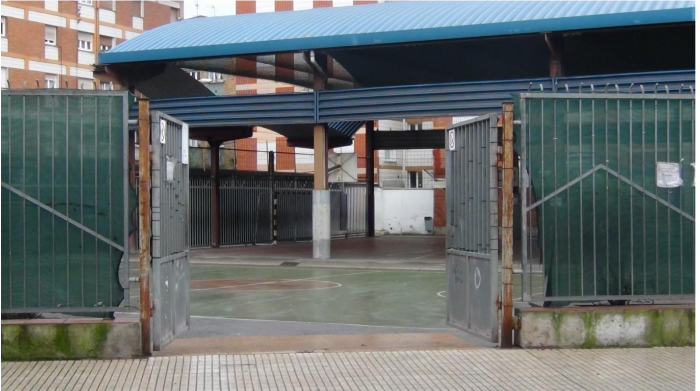
Acceso de vehículos al recinto escolar (C/ Fernando Poo) Ancho 3,12m
