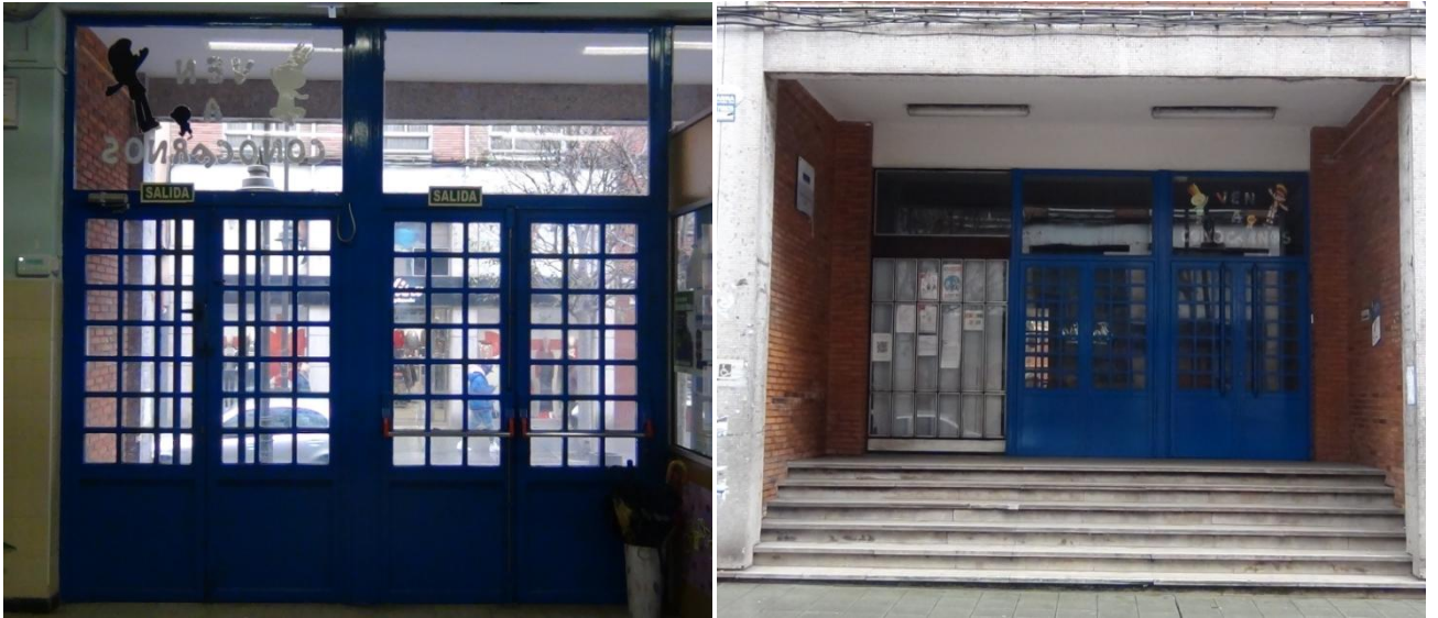
Puerta acceso Avda. Argentina (desde dentro, desde fuera)
