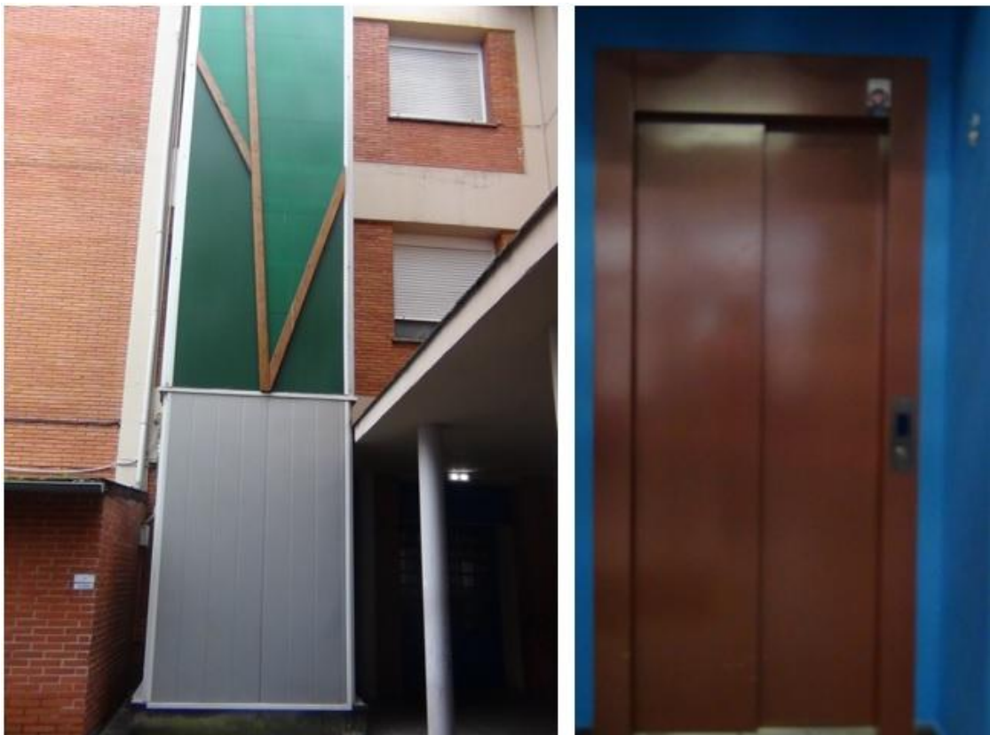
Ascensor (hueco exterior y puerta)
