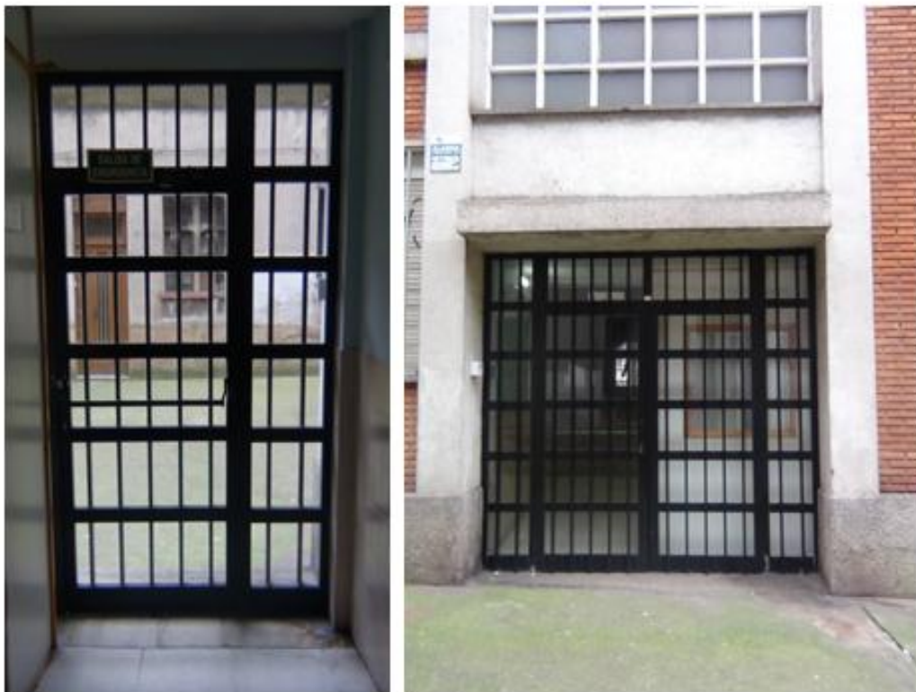
Puerta acceso al exterior desde Ala izquierda (desde dentro/desde fuera)
