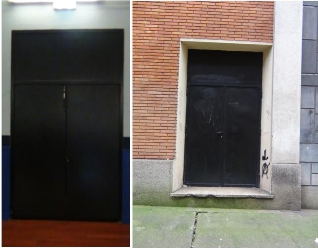
Puerta de acceso al exterior desde el gimnasio (desde dentro/desde fuera)
