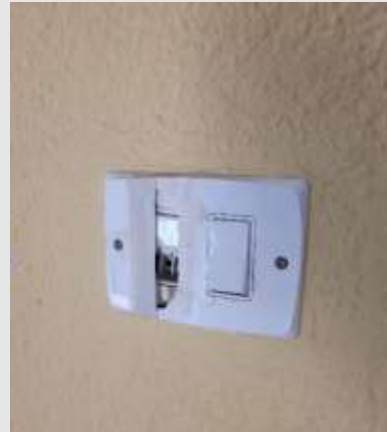
Pasillo 1ª planta junto a Aulas 5º y 6º PRI
