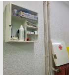
Pasillo a cocina planta baja Edificio Docencia
